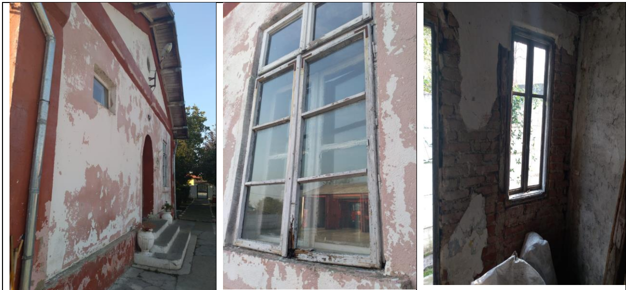
Figura 5 Starea actuală a clădirilor, ferestrelor, ușilor, sistemului de încălzire (soba cu lemne)
